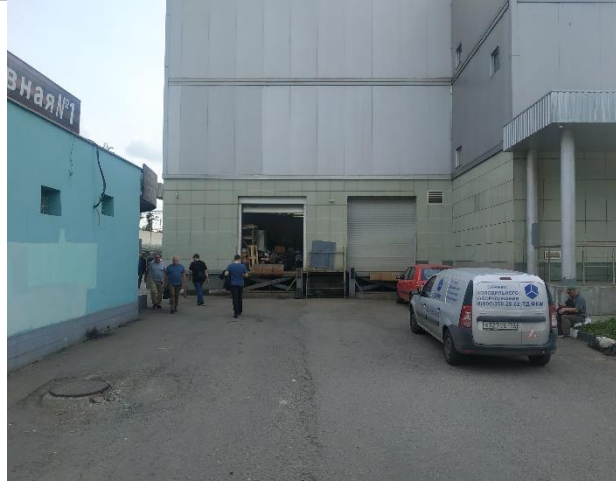
Фото 26. Фасад ТЦ и прилегающая территория
