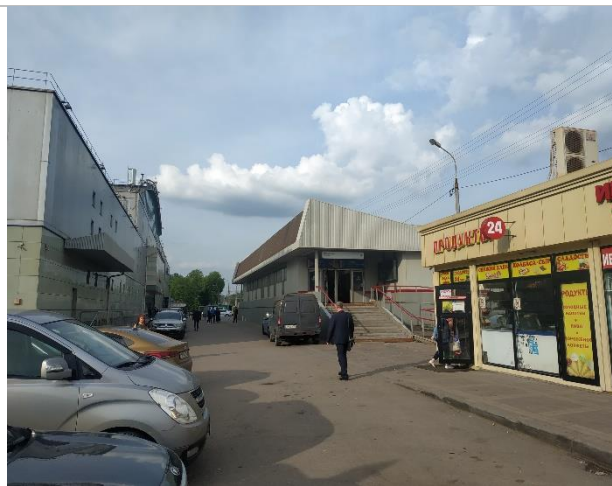
Фото 33. Фасад ТЦ и прилегающая территория
