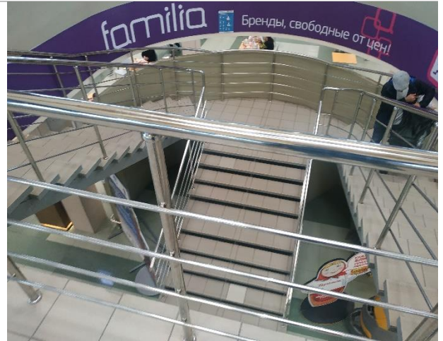
Фото 20. Фрагменты внутренних помещений ТЦ
