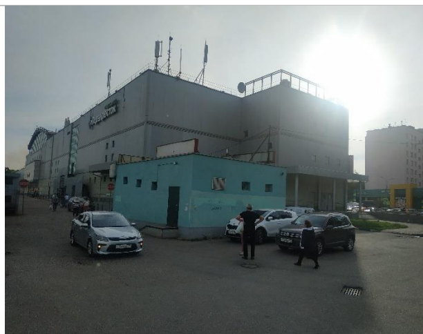
Фото 35. Фасад ТЦ и прилегающая территория
