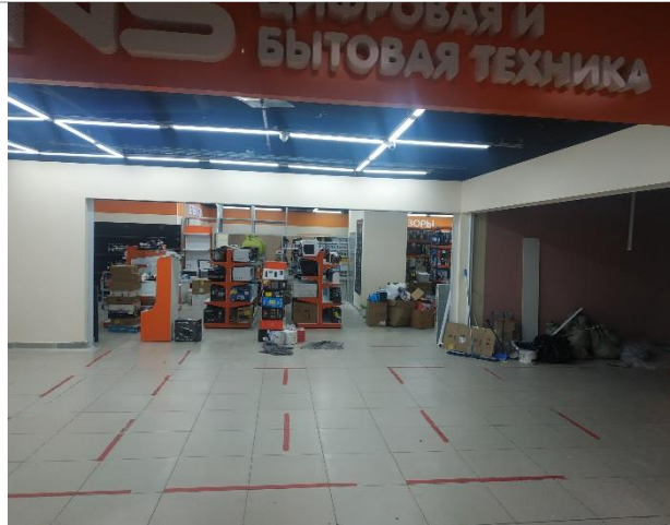
Фото 13. Фрагменты внутренних помещений ТЦ
