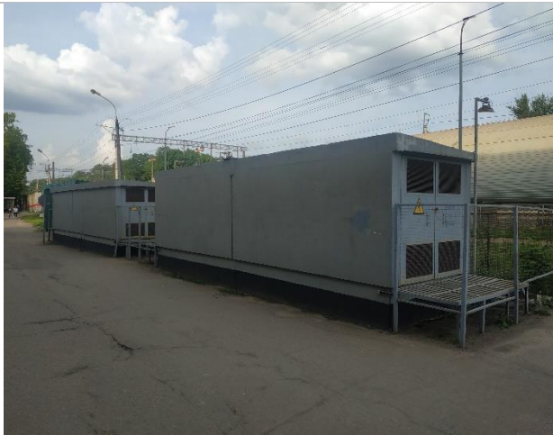
Фото 27. Здание ТП-282 и ТП-283
