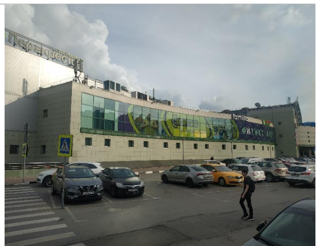
Фото 36. Фасад ТЦ и прилегающая территория
