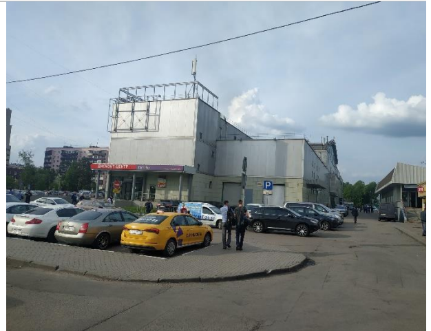
Фото 32. Фасад ТЦ и прилегающая территория
