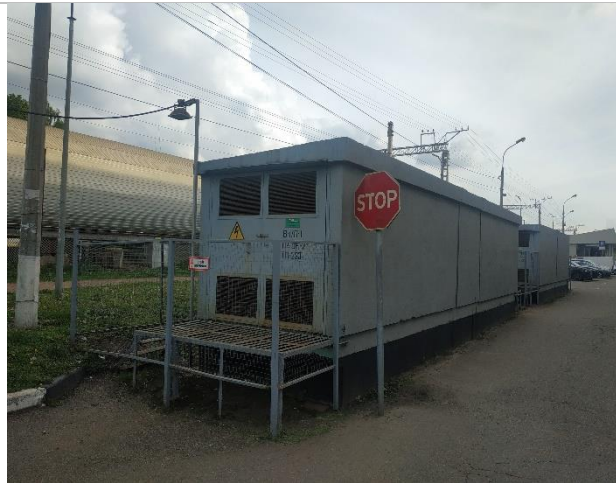
Фото 28. Здание ТП-282 и ТП-283
